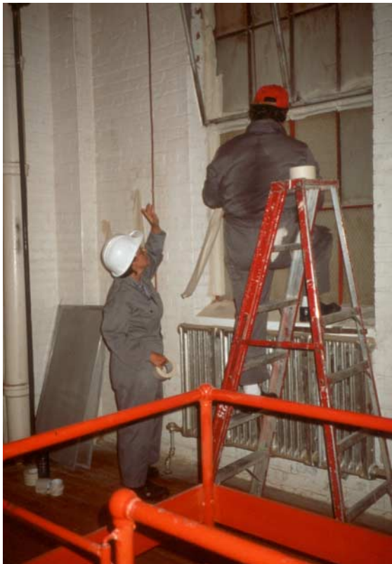
Masquage et étanchéisation des fenêtres.
