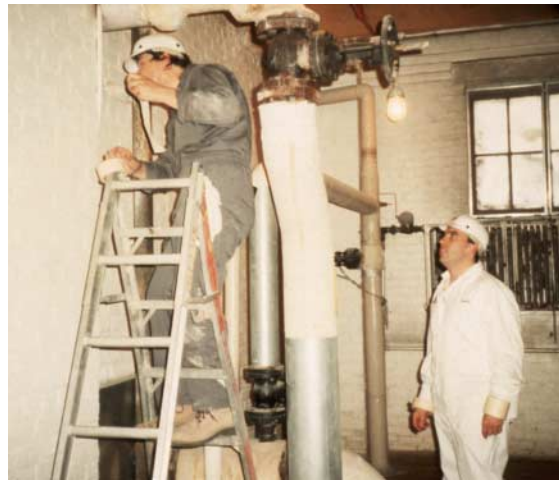
Masquage et étanchéisation des tuyaux.
